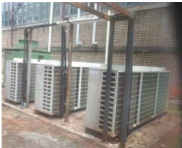
IMAGEM 15: Condensadoras VRF
